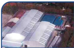
Techos de chapas
