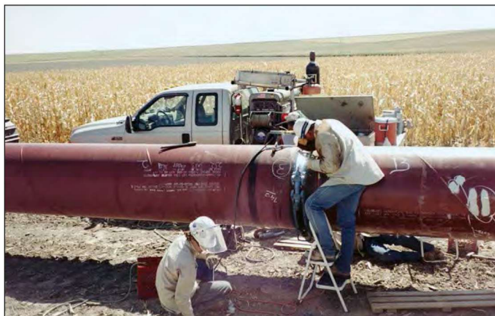
Soldadura de tuberías a campo travesía.
